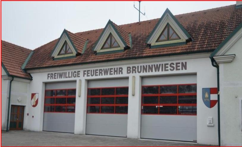
Im Außenbereich wurde bereits im November ein Teil des 1. Schrittes erledigt. Die alten Tore wurden von den Käufern ausgebaut und die 3 neuen Tore durch die Fa. Hörhan Fenster aus Ruprechtshofen, auf elektrische betriebene Tore ausgetauscht.
